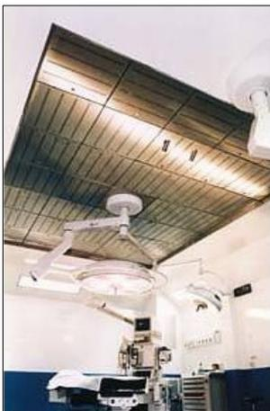
L'air qui arrive dans la salle de soin par le plafond est constitué à 30 % d'air neuf et 70 % d'air recyclé. 1/3 de l'air est extrait en partie haute de la salle pour éliminer les gaz anesthésiques plus légers que l'air.
