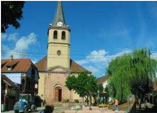
Le chantier du square Kuder entre dans sa dernière phase. (Photo DNA)
