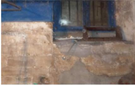
Le mur du sous-sol révèle une solide construction de pierres de taille en petit appareil.
