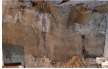
L'angle sud-est, dégagé lors de transformations, révèle un chaînage en grand appareil.
