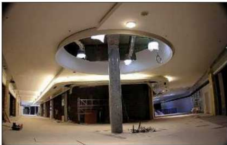
Les invités de l'Apecet, association des commerçants, ont été surpris par l'ampleur du chantier et l'espace offert aux boutiques. 11 000 m 2 de surface commerciale. 6 700 m 2 dévolus aux futures 36 boutiques... Vu de l'intérieur, c'est impressionnant.
