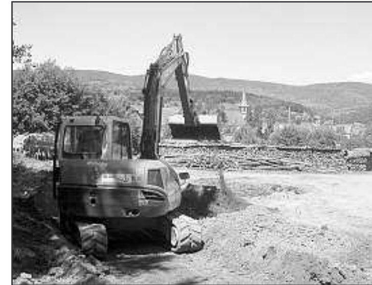
Les travaux pour la tranche Villé-Basseberg ont commencé. Photo Arsène Humbert
