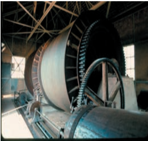
Transporteur aérien : installation de remplacement du câble (tous les 3 mois, le câble était changé) elles étaient situées à Maxéville et à Lenoncourt
