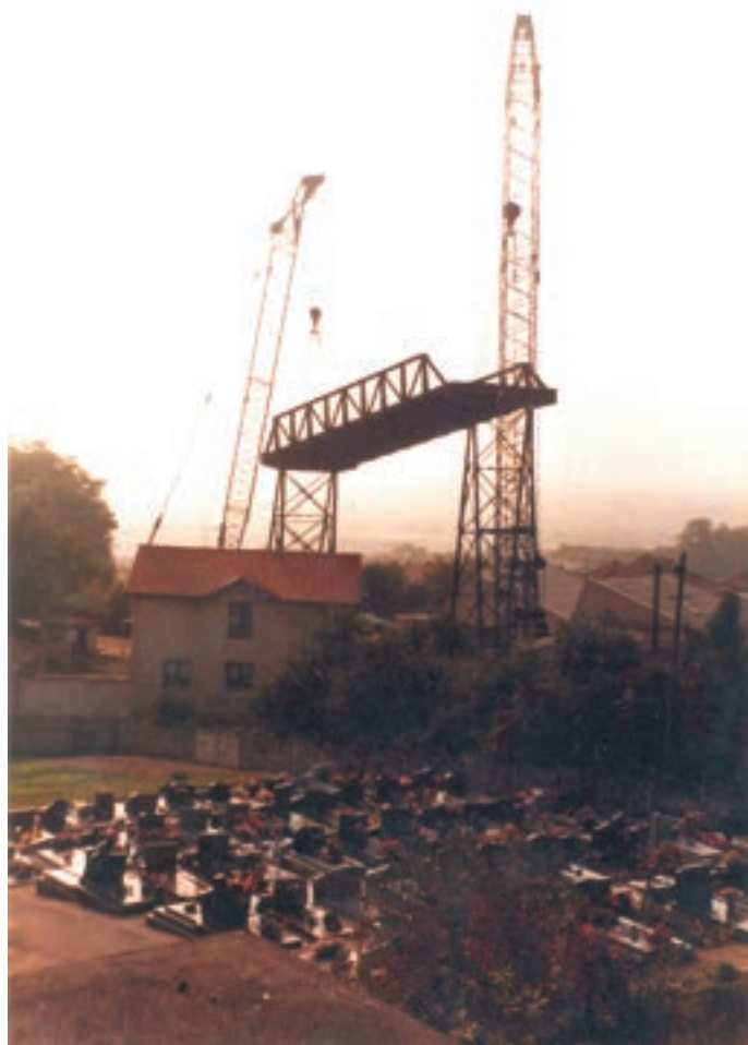
démontage du transporteur aérien - l'ouvrage de protection de la rue de la justice à Maxéville. Au dessus du cimetière, en 1985
