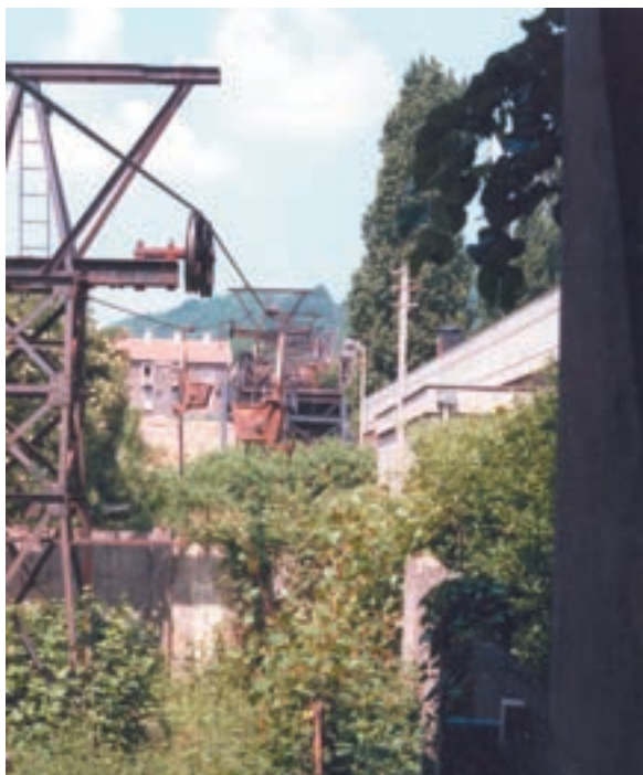
Vue d'une partie de la ligne du transporteur dans la traversée de Maxéville. On aperçoit l'ouvrage de protection du canal et au fond la trouée dans la forêt au sommet de la côte
