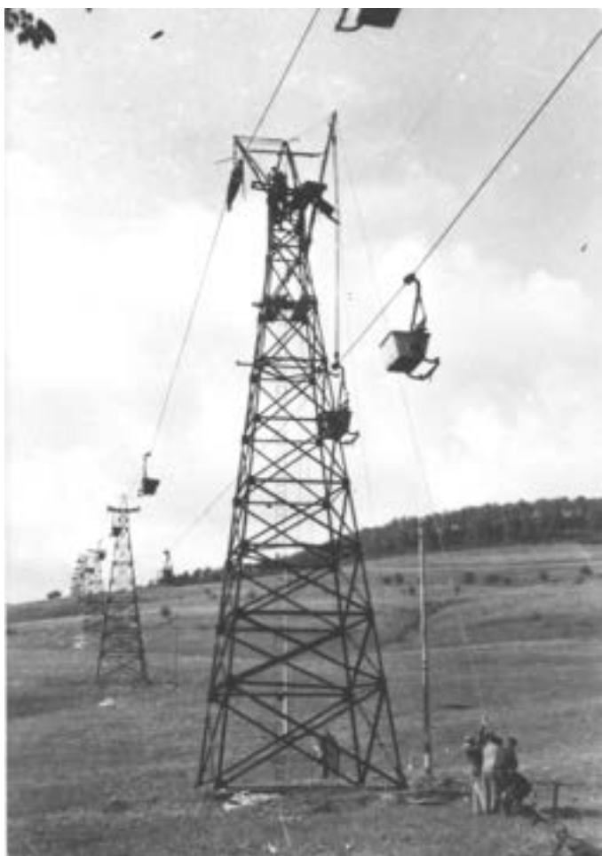
Transporteur aérien vers 1950 réparation d'une poutre de support des poulies de pylone
