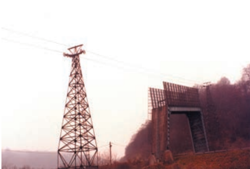
Transporteur aérien - ouvrage de protection au dessus de l'A31 (photo prise à l'occasion d'une opération de remplacement du câble vers les années 80)
