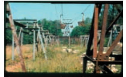
Transporteur aérien à la station de relais de Lenoncourt - garage de bennes pendant le remplacement des câbles
