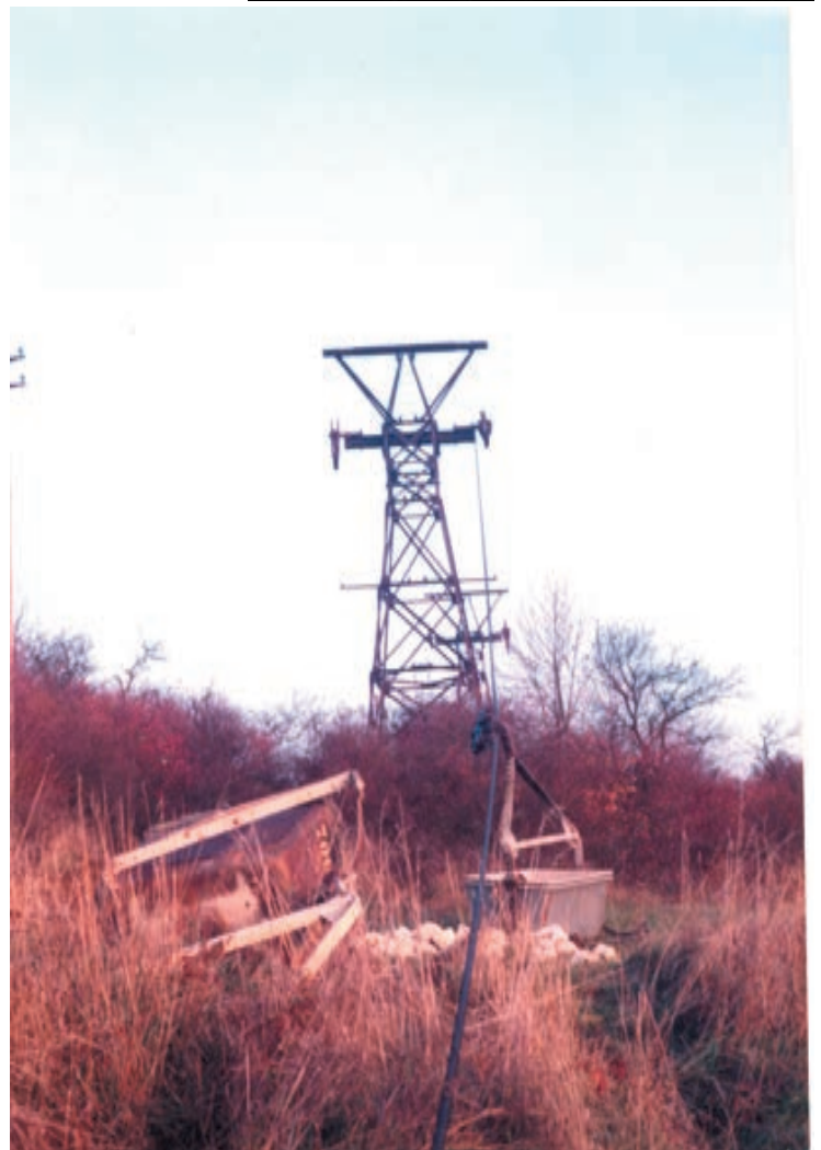
Transporteur aérien rupture accidentelle du câble en novembre 1983 à Essey
