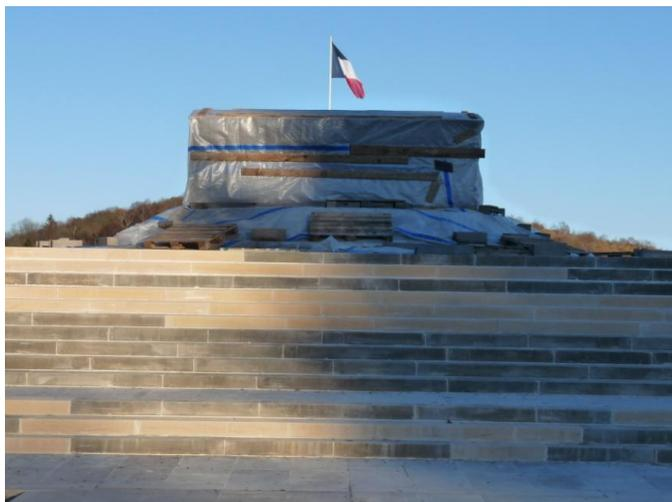
Les travaux de reprise et de réparation des supports béton existants ainsi que de protection et de passivation des aciers sont réalisés sur toutes les structures périphériques de l'Esplanade.
