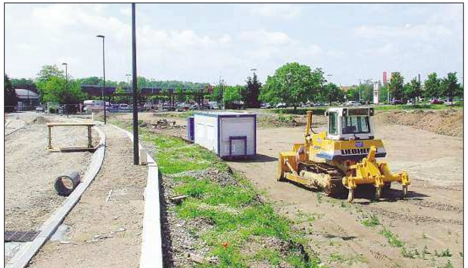
Les travaux de voirie se terminent et les premières constructions vont débuter prochainement. Photo BH
