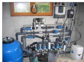
Exemple de local technique de piscine
