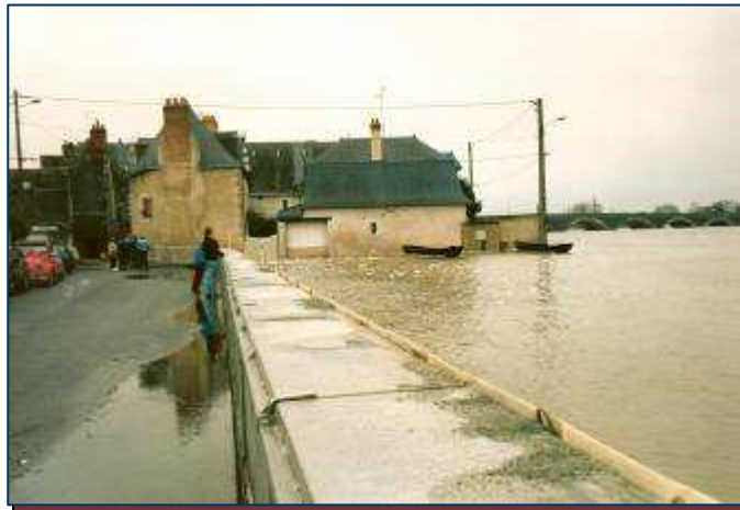
La digue installée sur le Port des Noues – crue de 1994
