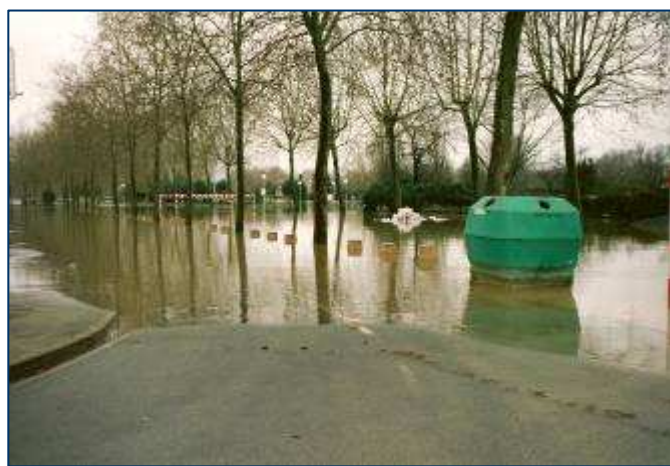
Avenue de la Boire Salée – crue de 1994
