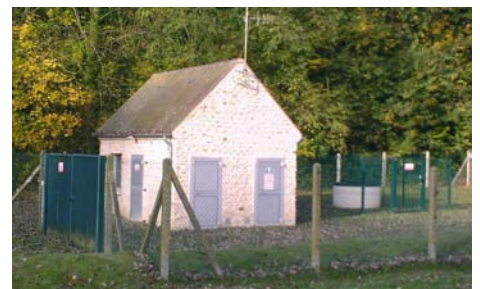
Le puit de captage d'eau de Montagny
