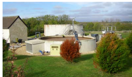
Boubiers, une des premières communes du canton à avoir réalisé son assainissement collectif
