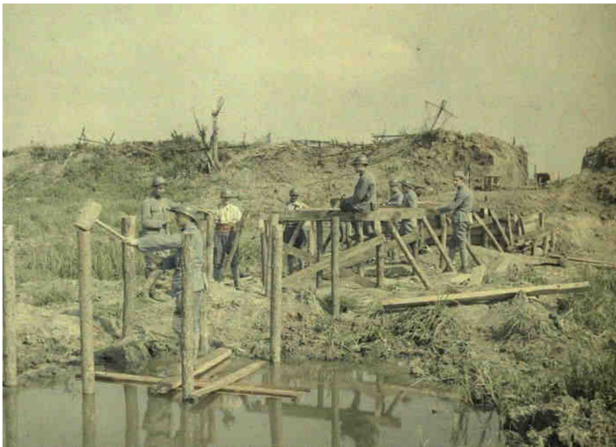
Construction d'une passerelle sur les trous d'obus. Commune de Boesighe. (Belgique 10 septembre 1917). photo couleur frères Lumière
