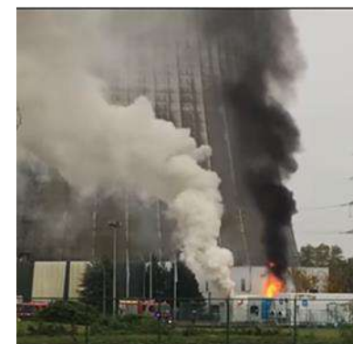
Incendie container batterie Drogenbos (B)
