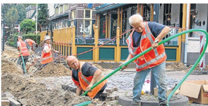
A Nuenen, petite cité du Brabant où vécut Van Gogh, 7.500 logements ont été raccordés un à un au réseau de fibre optique OnsNet (« notre réseau »), qui a nécessité le creusement de 120 kilomètres de tranchées à travers la ville.
