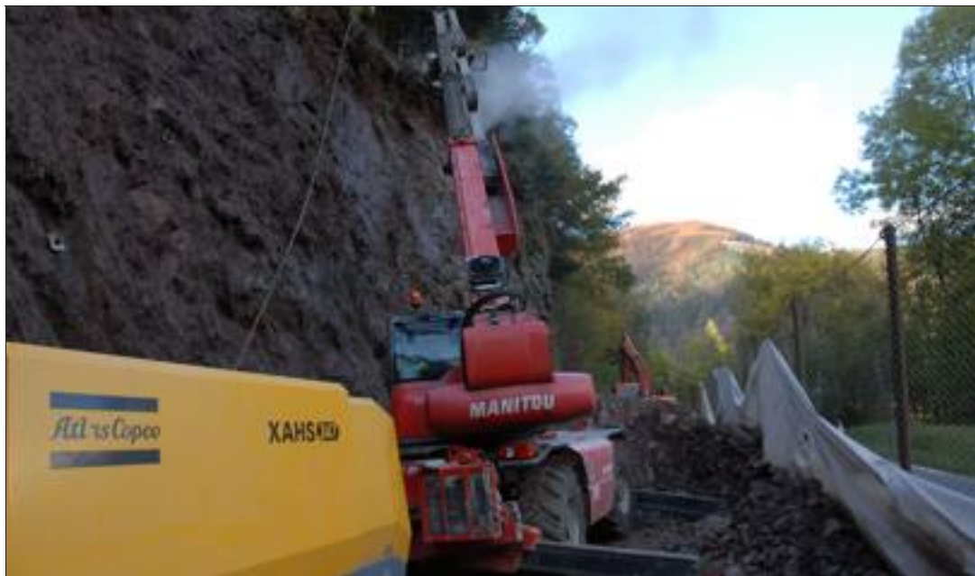
Une falaise entière doit être reprofilée dans la montée du col de Bussang depuis Urbès. Photo A. V.
