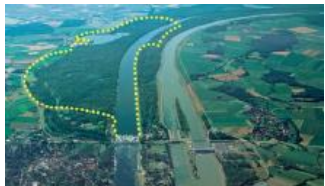
Zone de rétention des crues à Breisach
