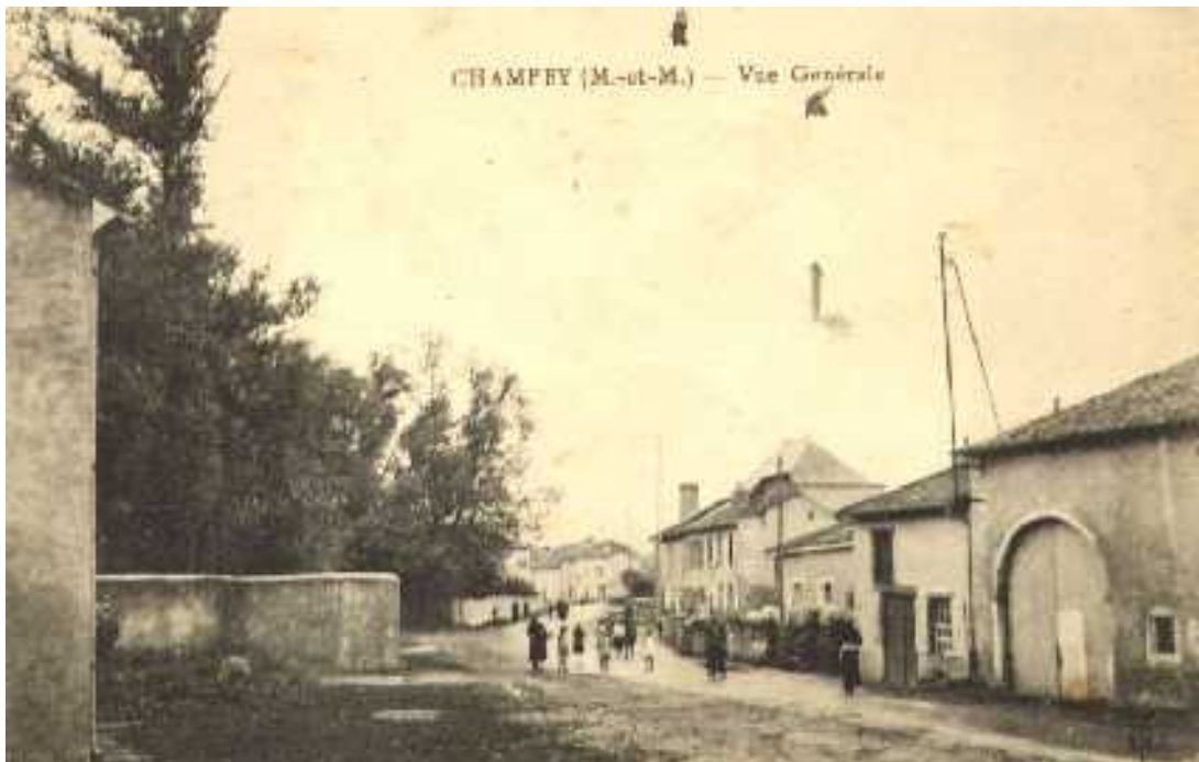
Entrée de Champey en venant de Vittonville avec la maison des Hackenheimer On passait sous la voûte datant de 1630 et on accédait à l'étage par un escalier, derrière cette arche se trouvait le pressoir communal
