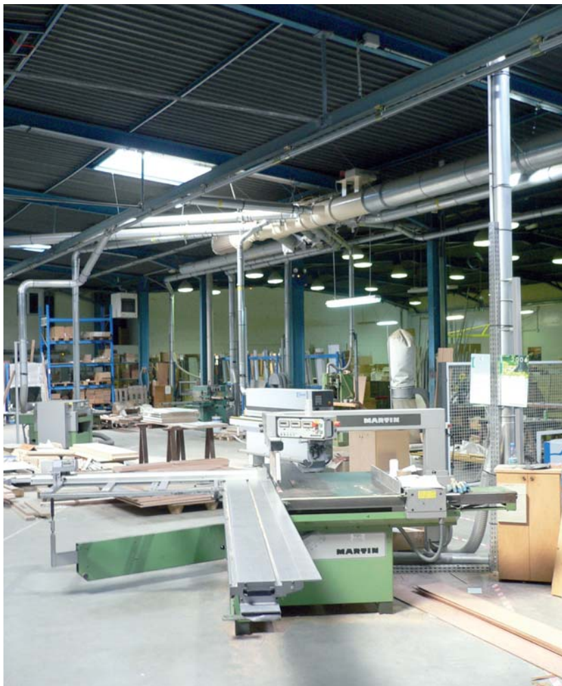
L'installation du réseau à débit variable a mis à contribution plusieurs partenaires institutionnels et techniques.
