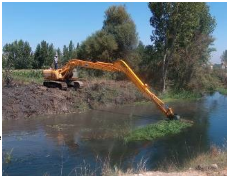
Réhabilitation Environnemental Gabions Et Nettoyage par machine adaptée (Long Bras)
