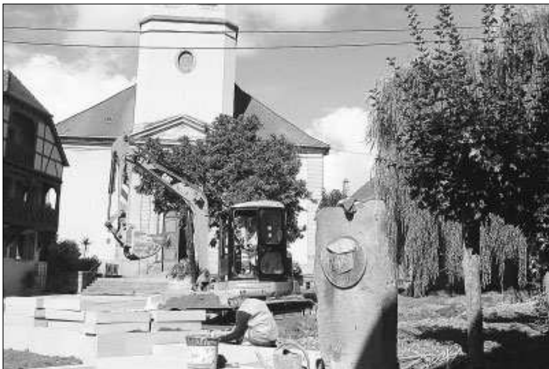
Le chantier du square Kuder va bientôt se terminer.
