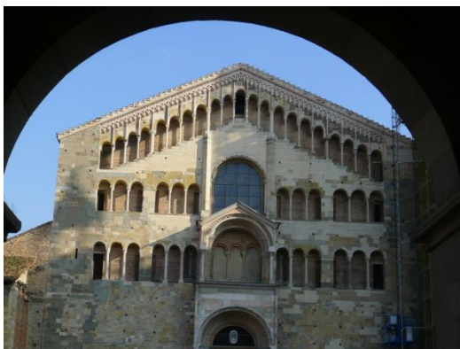
La partie haute de la façade
