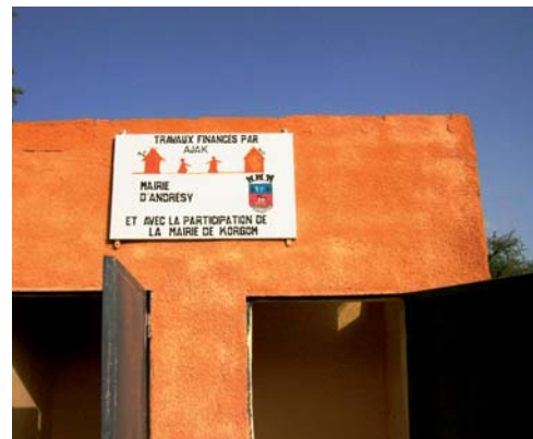
Fin de la construction des latrines
