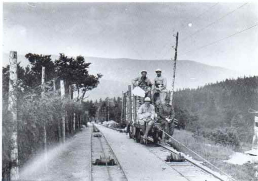
Funiculaire militaire. Plan incliné du Gazon du Faing, 6 août 1916 (coll. SIRPA/ECPA France).
