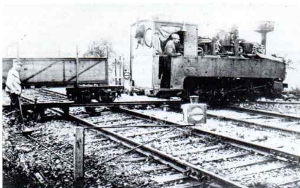
Locomotive DFB franchissant une ligne à voie normale par une "sauterelle" (coll. Gottwaldt, avec autorisation).
