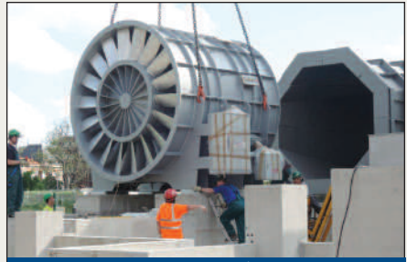
Construction d'une soufflerie à l'INSAE-SUPAERO
