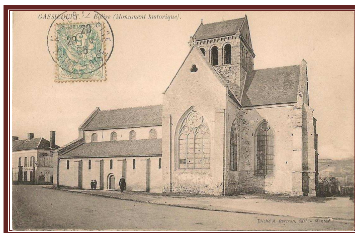
Église de GASSICOURT
