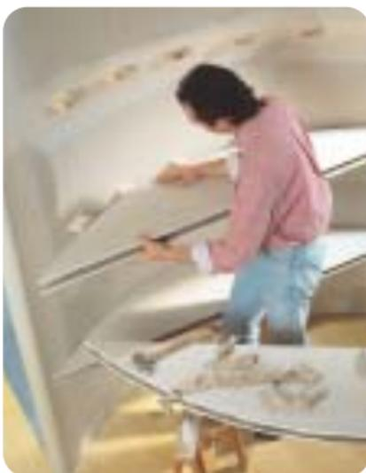
A l'aide d'une scie égoïne, découpez les tablettes dans des panneaux Placopan®, et lissez les chants avec le rabot spécial plaque de plâtre.
