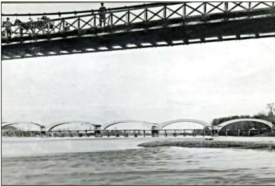
CASTELSARRASIN - le Pont de Chemin de fer et le Pont suspendu de Belleperche
