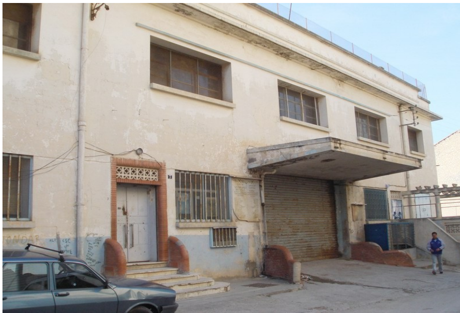
Voici ci-dessus la vue de l'entrée rue Sabri Abdelaziz. On voit l'entrée des bureaux, une entrée de marchandises et l'entrée du petit logement de gardien qui fait partie de l'immeuble
