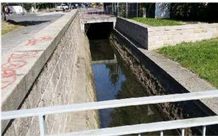
Le Petit Rosne demeure canalisé sur plusieurs parties de son cours: le débit est limité à 5 m<sup>3</sup>/seconde... C'est donc un point de blocage à résoudre quels que soient les aménagements de réouverture
