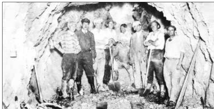
Quand le tunnel se creusait à la main...
