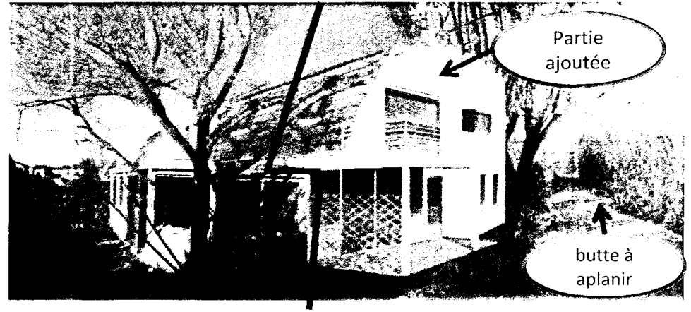
Vue de la route (façade est) après travaux
