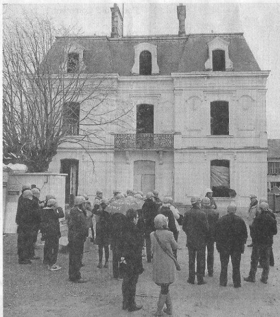
Le caractère authentique de la grande maison bourgeoise va être sauvegardé dans le projet d'en faire un hôtel de standing.
