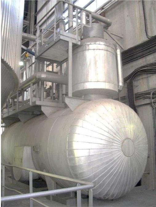
Fig.5 – Ensemble Tour de dégazage thermique sur bêche alimentaire
