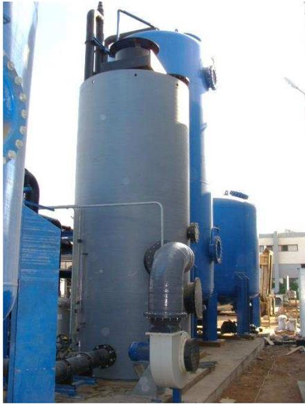
Fig. 2 – Dégazeur atmosphérique 155 m3/h. Au premier plan le ventilateur d'insufflation d'air, en partie haute le dévésiculateur (séparateur de gouttelettes)
