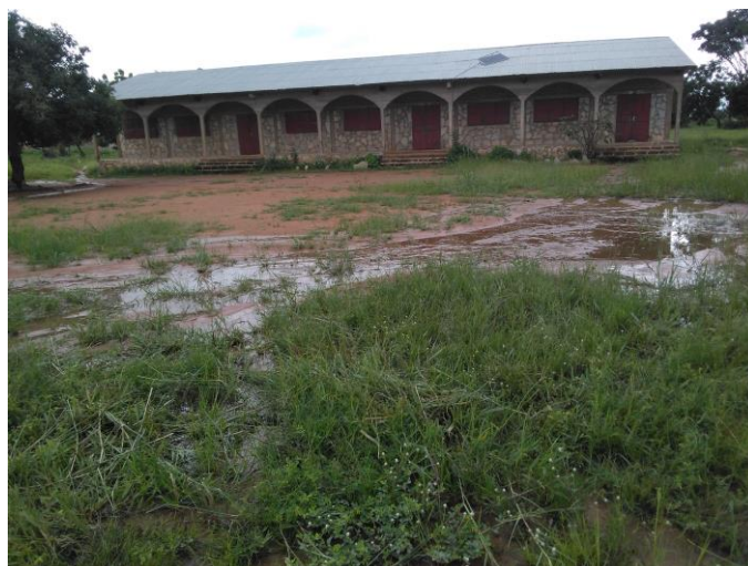
La cour de l'école enherbée et inondée
