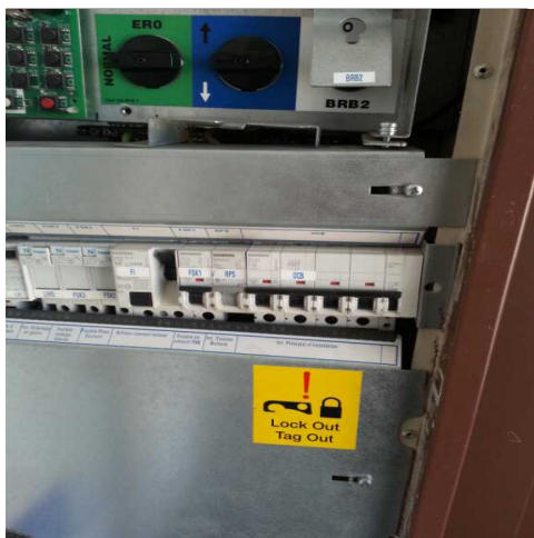
Le tableau d'arrivée de courant.
