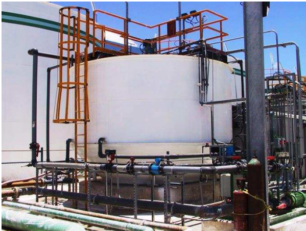
Fig.2 – Décanteur décarbonateur
