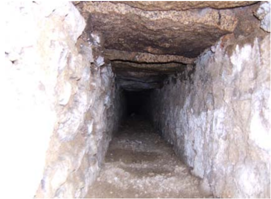
Photo 10 : Intérieur du drain de Kérénic
