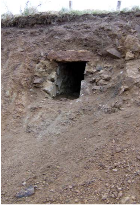
Photo 9 : Coupe du terrassement de Kérénic
