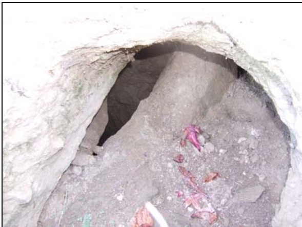
Photo 11 : dalles en bâtière effondrées
