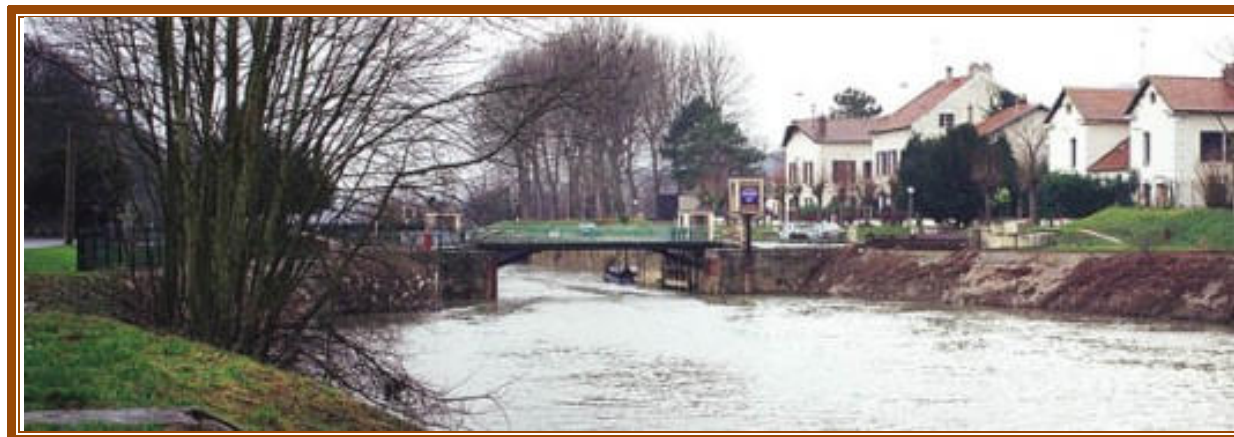
L'écluse des Mureaux
