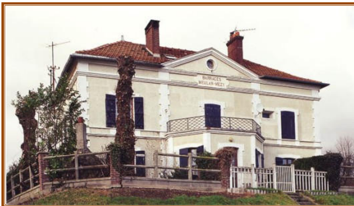
La maison du barrage et de l'éclusier de Mézy-sur-Seine
