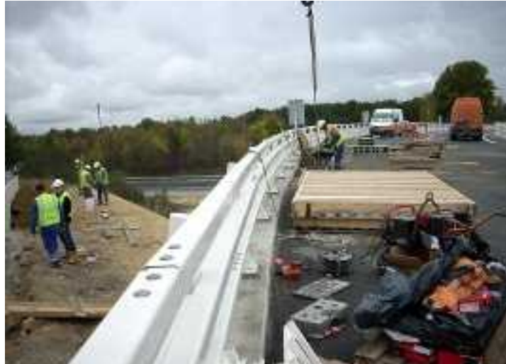
Environ 110.000 heures de travail ont été nécessaires pour une moyenne de 80 personnes sur ce chantier.
