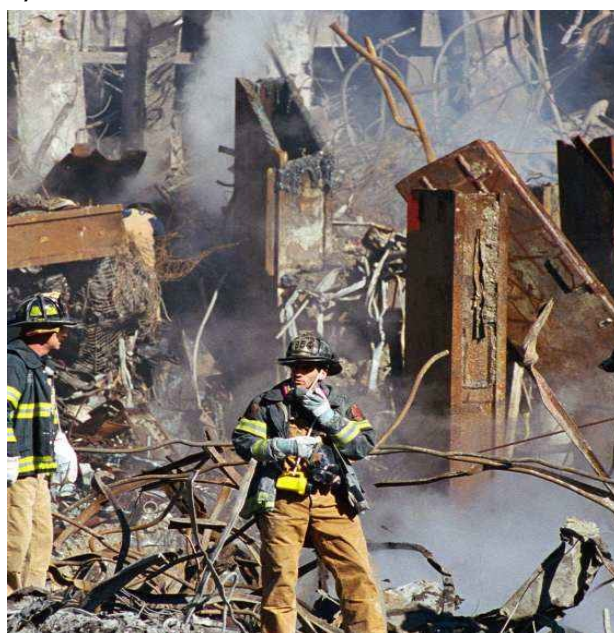
Les poutrelles d'acier après l'effondrement
