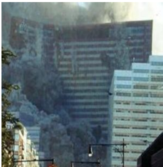
Effondrement de la tour 7 à 17h30
