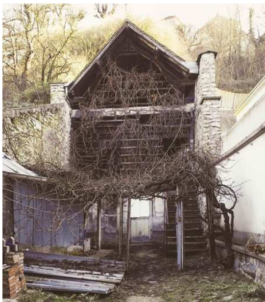
Ancienne tannerie de Meulan grenier étendoir des peaux avant travaux de restauration
