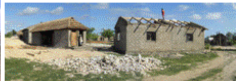
Chantier Mangily Forêt en cours de finition
