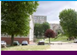
LE QUARTIER DES BERGERIES À DRAVEIL EN RÉHABILITATION.
