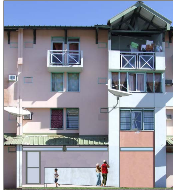
Photo montage de la façade côté rue
